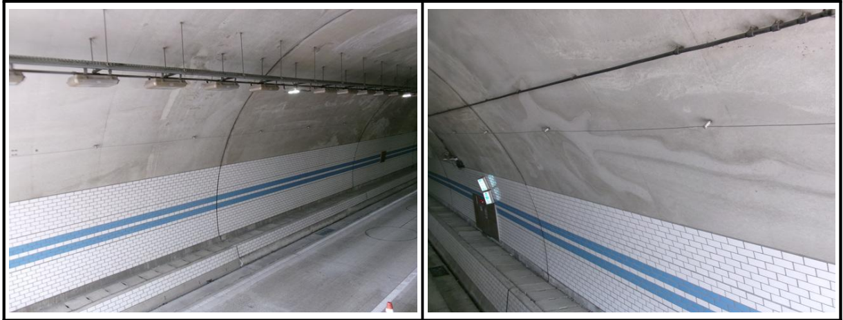
【사진 3.3.3】 라이닝 측벽부 전경
