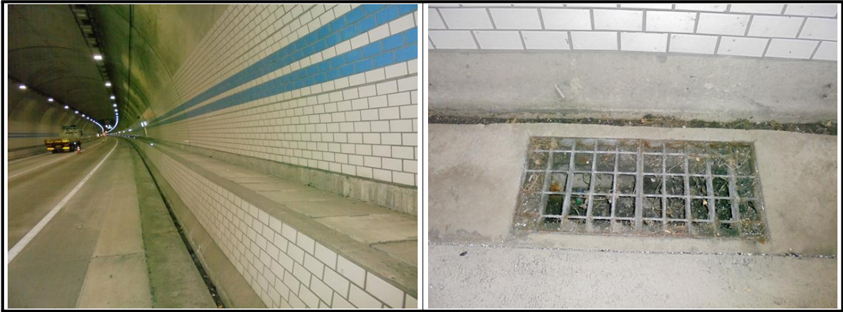
【사진 3.3.9】 공동구 및 배수시설 전경
