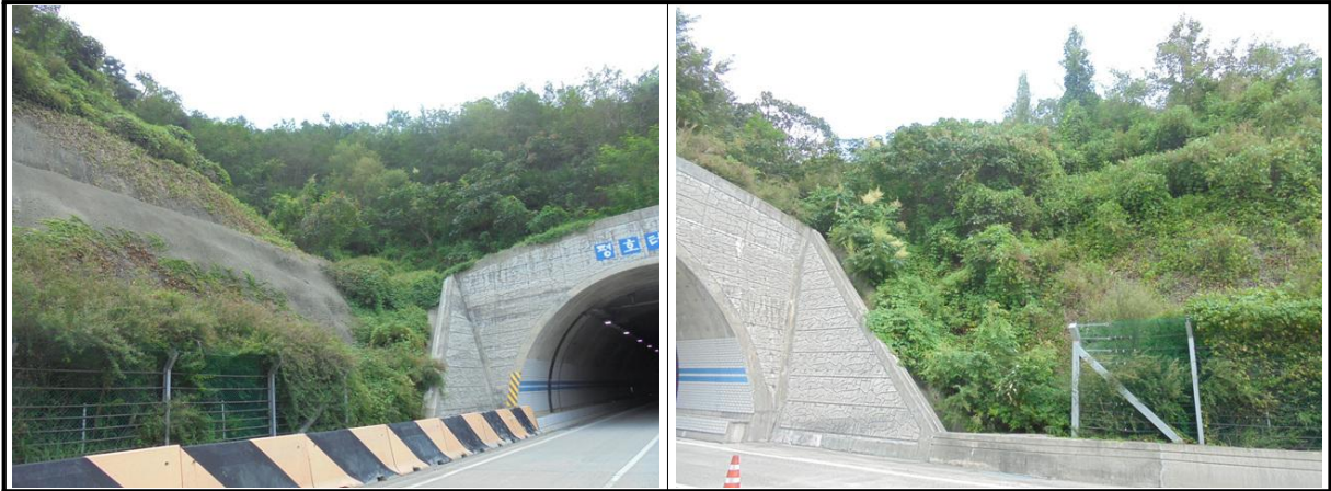
【사진 3.3.21】 사면 전경
