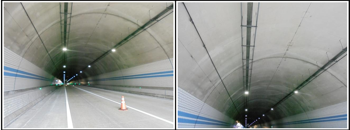
【사진 3.3.1】 라이닝 천단부 전경
