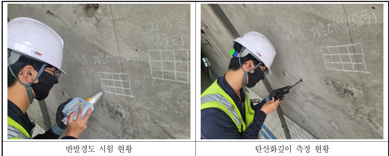
【사진 3.4.1】 콘크리트 내구성조사 현황
