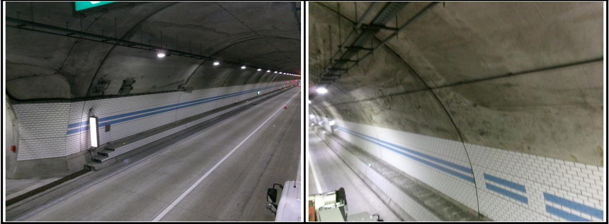
【사진 3.3.17】 라이닝 측벽부 전경
