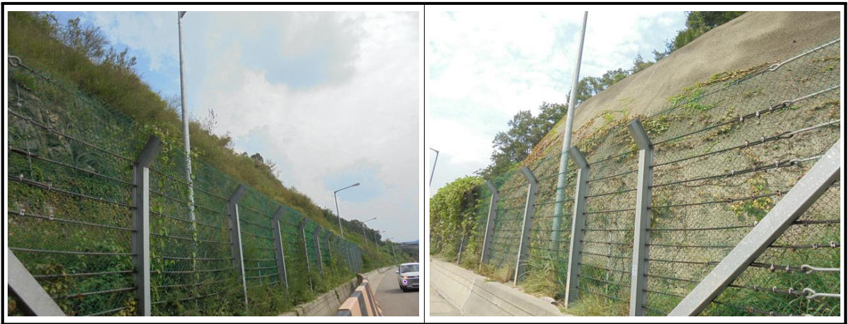
【사진 3.3.7】 사면 전경
