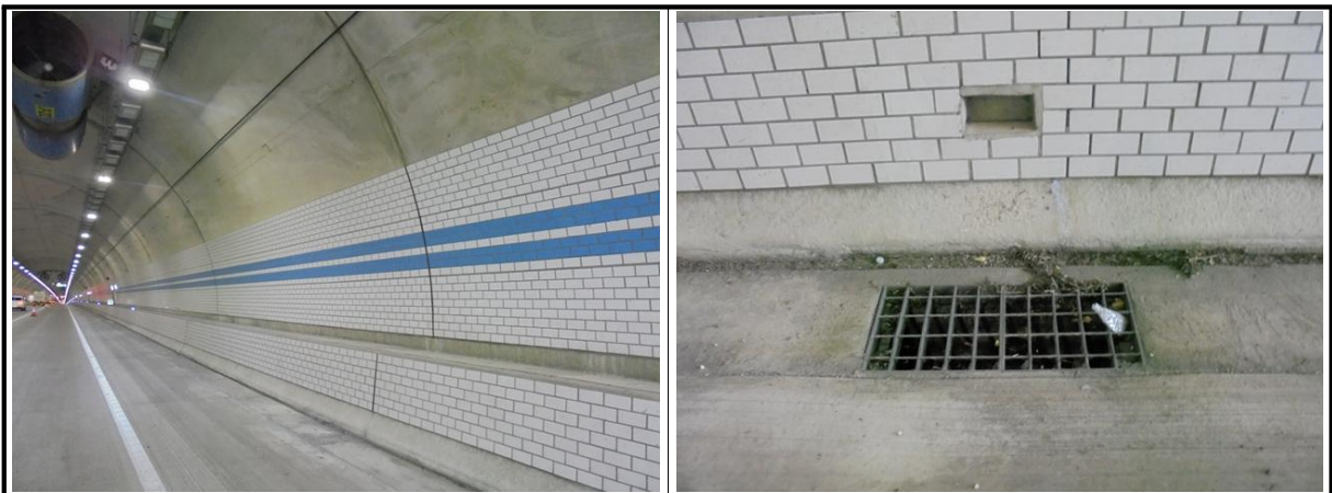
【사진 3.3.23】 공동구 및 배수시설 전경
