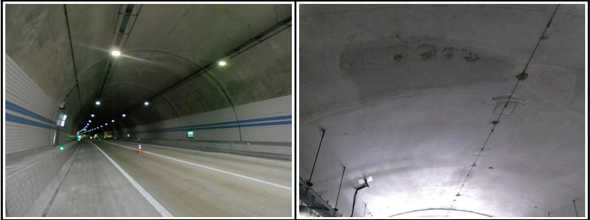
【사진 3.3.15】 라이닝 천단부 전경
