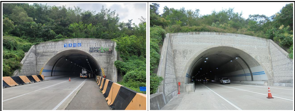
【사진 3.3.19】 갭문 전경
